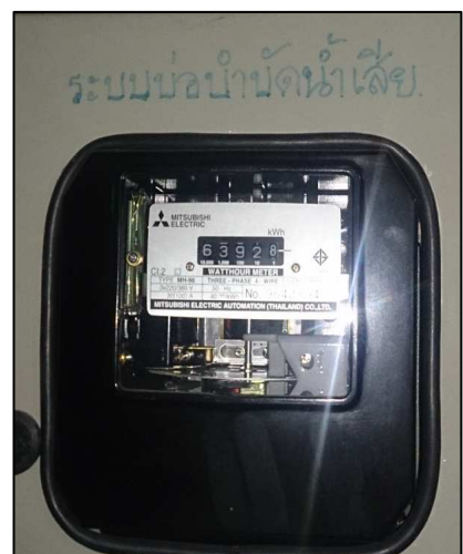
ภาพที่ 2-6 อุปกรณ์ประหยัดพลังงาน, ป้ายรณรงค์ประหยัดพลังงานไฟฟ้า และมีเตอร์ไฟฟ้าแยกเฉพาะระบบบำบัดน้ำเสีย
